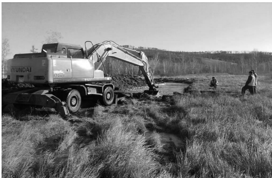
Рисунок 2 – Выемка грунта экскаватором по трассе нагорного канала
